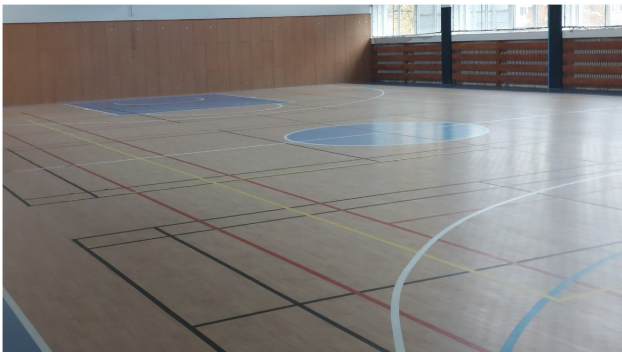
Rekonstrukce podlahy v tělocvičně
