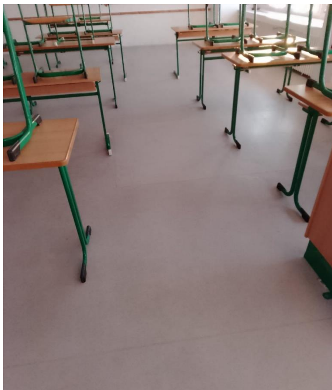
Nová podlahová krytina uč. 322
