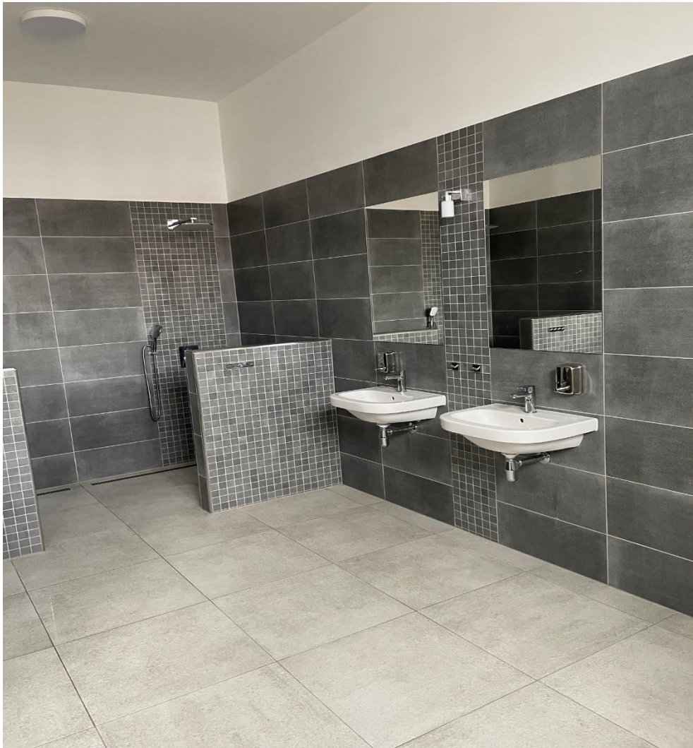
Rekonstrukce umývárny chlapců
